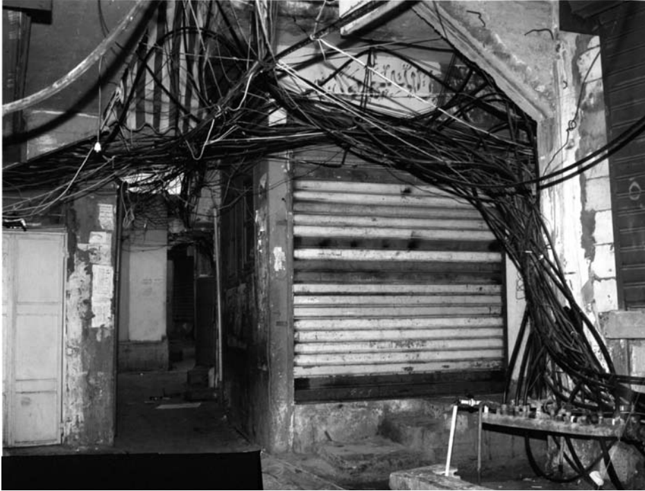
إحدى شبكات توزيع المياه في المخيم
